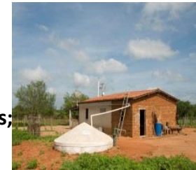
Cisterna de placas de 16 mil litros
