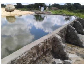
Tanque de Pedra
